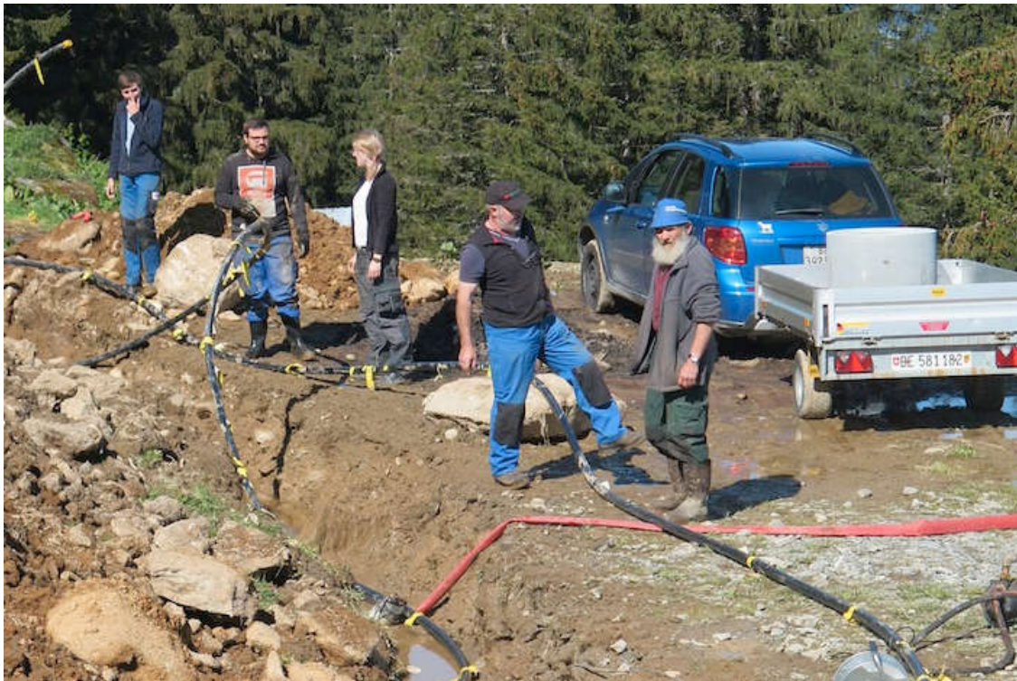
Der Aushub eines Grabens für die Verlegung einer Leitung benötigte viel Kraft.
